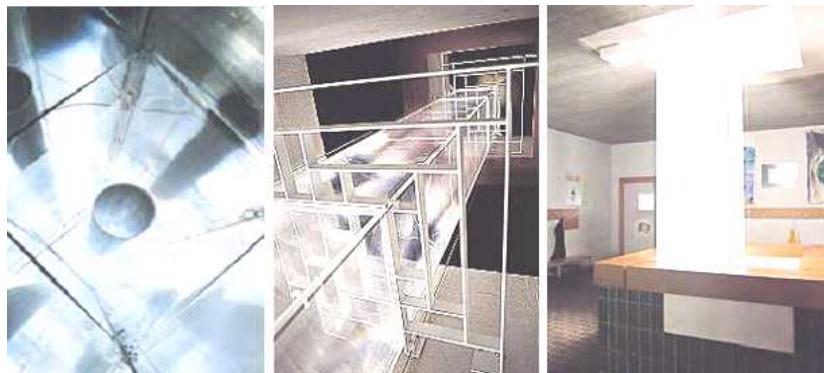
그림 10. 설비형 채광시스템 산란부(좌), 전송부(중앙)와 시스템 설치 예(우)
