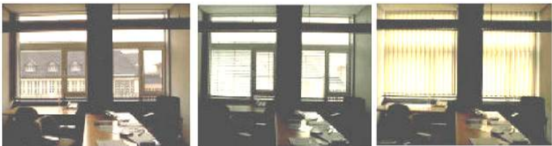
그림 7. 투명유리, 수평블라인드, 수직블라인드를 설치한 측창
