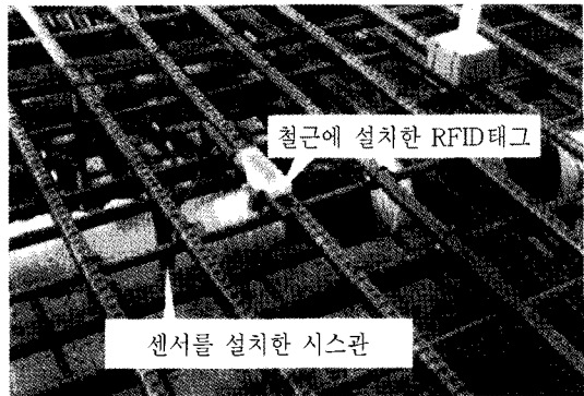
〈사진-3〉 설치 상황
