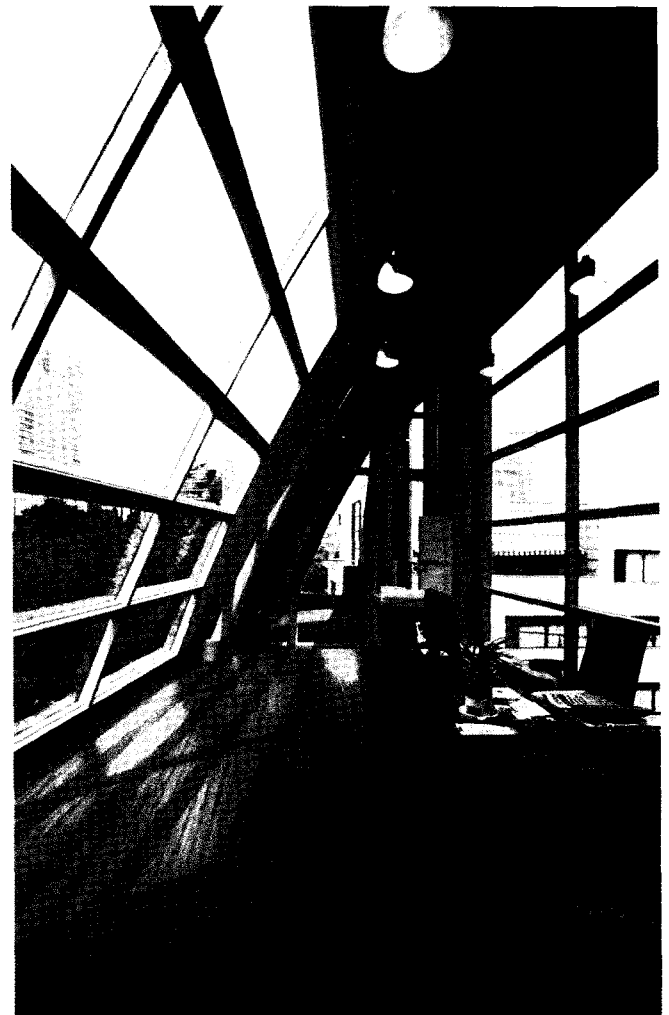
서초동빌딩 전경(위), 내부(아래)
