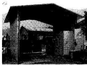
【그림 2】 농장입구에 설치된 차량 소독장치
