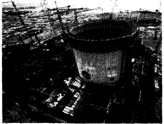
신고리 3호기 원자로건물 건설현장
