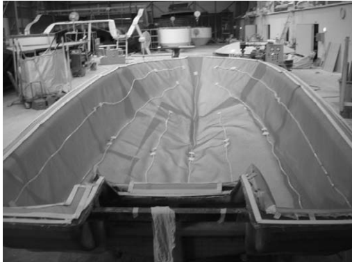
Fig. 10 스파이럴 튜브 설치
