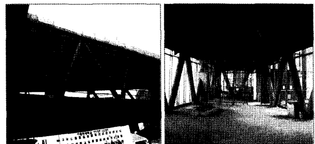
〈OVER BRIDGE 시공사진〉
