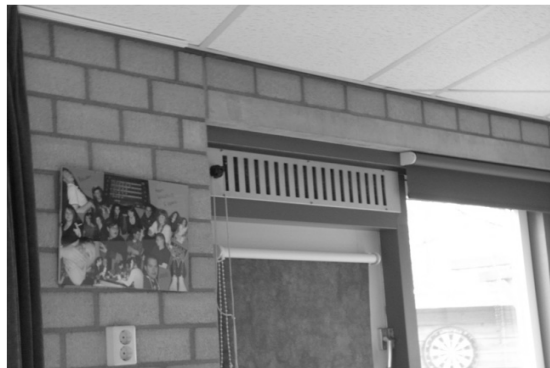
그림 15. 실 내부 및 외기유입을 위한 슬릿형 급기팬
