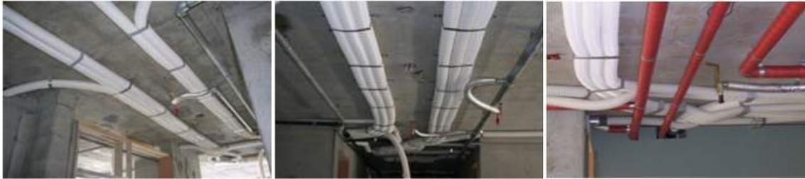
그림 8. 플렉시블 에어호스를 이용한 시공사례
