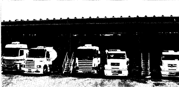
[그림 7] Leplan 정유공장에서 E25를 탱크로리에 Loading하는 사진 (탱크로리 사이에 있는 계단 밑에 [그림 6] in line mixer가 설치돼 있음)
