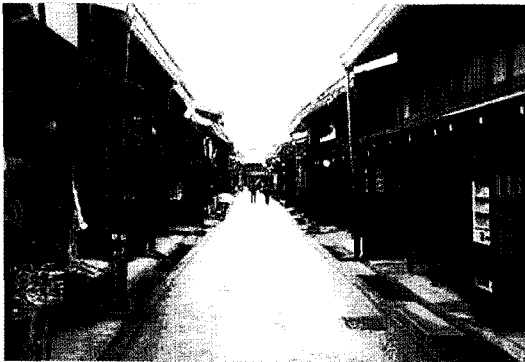
[사진4] 고산시삼정 중요 전통적 건조물군 보존지구의 마치나미 도로의 측구는 화재 시 상류의 방화용수를 급수하는 경로이기도 할.
