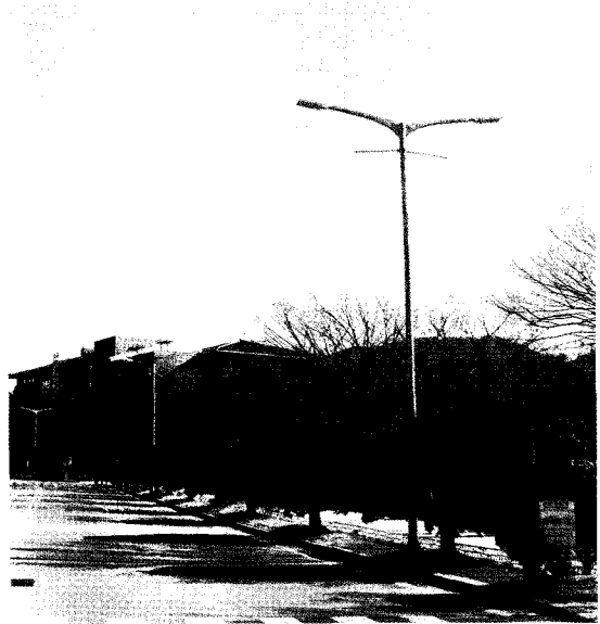
▲경기도 하남시 가로등 DR 시리즈 설치
