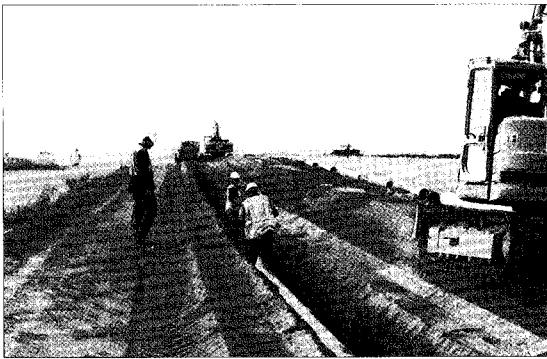
<그림 6> 물 공급을 위한 파이프라인 건설 전경
