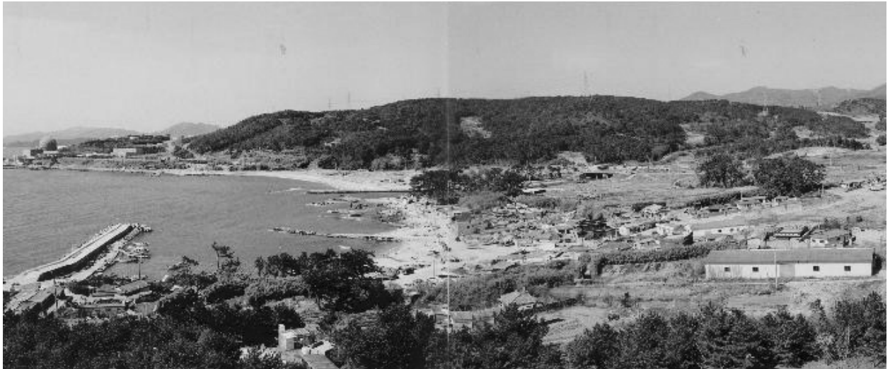
공사전 부지 전경
