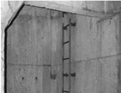
(a) 에어클리너 설치전
