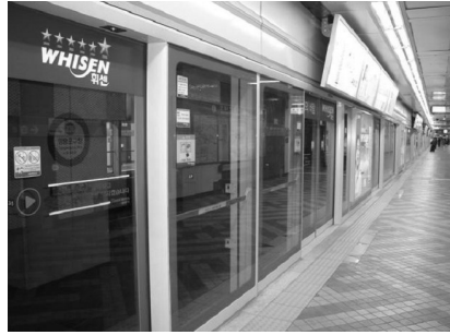
(b) 스크린도어 설치후
