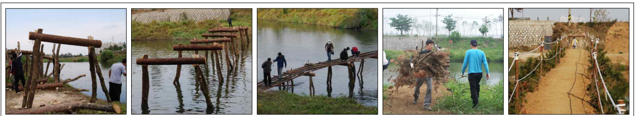
그림 4. 섯다리 놓기 과정(Y자목고정 → 다릿발배열 → 널래얹기 → 섯얹기 → 부직포 깔고 마사토포설 → 난간설치 )
