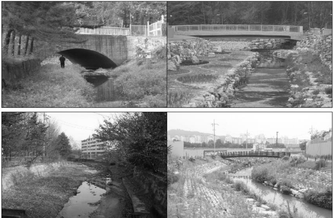
사진 2. 화랑천 정비 전(좌)과 후(우) : 통수단면의 확대와 더불어 아름다운 조형물 그리고 친환경적인 정비가 어우러진 모습
