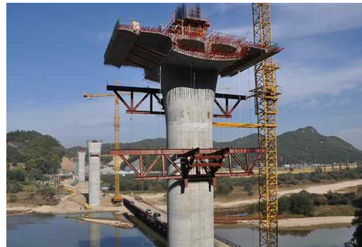
사진 3. 주두부 가시설 해체
