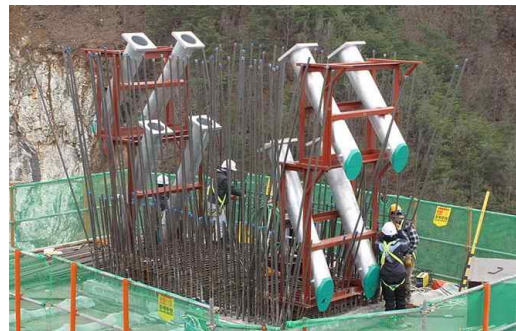
사진 5. 주탑부 가이드 파이프 설치
