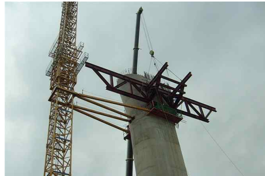
사진 2. 주두부 가시설 설치
