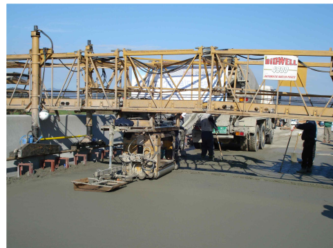
(a) 포장 콘크리트 타설
