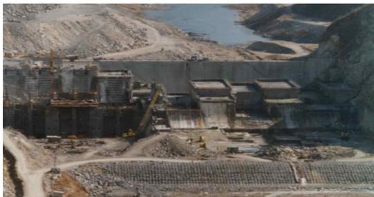
사진 1. 블록 타설식 콘크리트 댐의 시공(합천댐)
