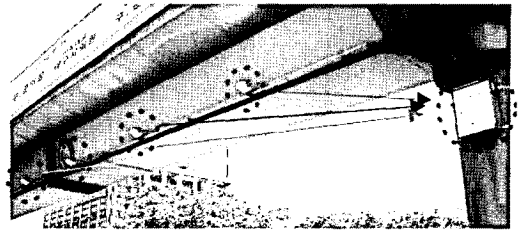
그림 3. 대구광역시 달서구 성서 초등학교 앞 육교에 설치되어 있는 RFID 리더기와 안테나
