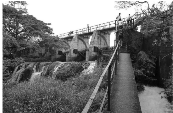
사진 2. Kimbulwana Oya 저수지의 물넘이와 간선수로 시점
