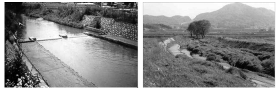
a) 시공직후 b) 토사유입으로 인한 기능상 (a) 플라스틱과 자갈을 이용한 복합접촉산화수로
