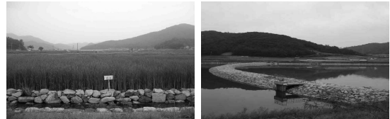
그림-2. 감둔저수지에 설치한 인공습지(좌) 및 오염물질침강지(우)
