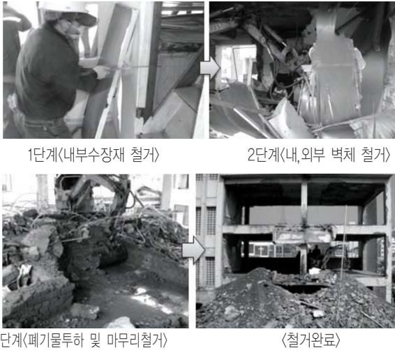
그림 6. 기존방식의 철거 단계별 전경
