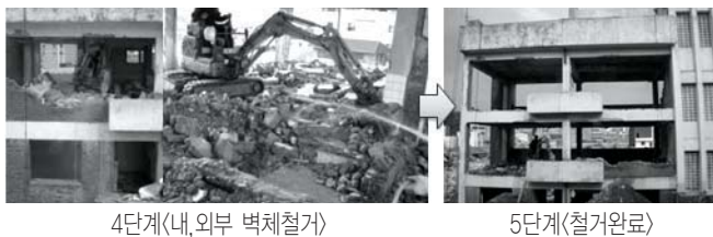
그림 7. 신규방식의 철거 단계별 전경
