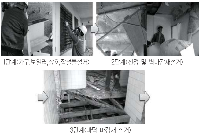
그림 6. 기존방식의 철거 단계별 전경
