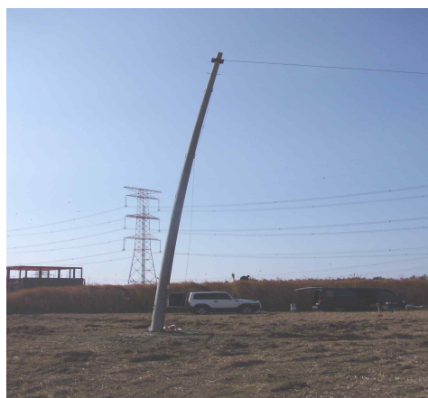
그림 1. 전주 인장시험 Fig. 1. Tensile test of electric pole
