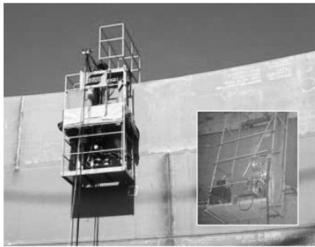
Fig. 1 육상식 LNG Tank의 Horizontal SAW용접
