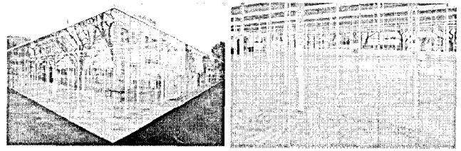
a) 건물외관, 프레임이 사라진 유리 외피의 미니멀 디테일 b) 내진설계를 위한 다양한 지름과 자유롭게 배치된 기둥들에 의한 영역설정
