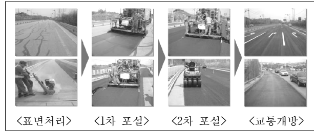
그림 3. 본 기술의 시공 장면
