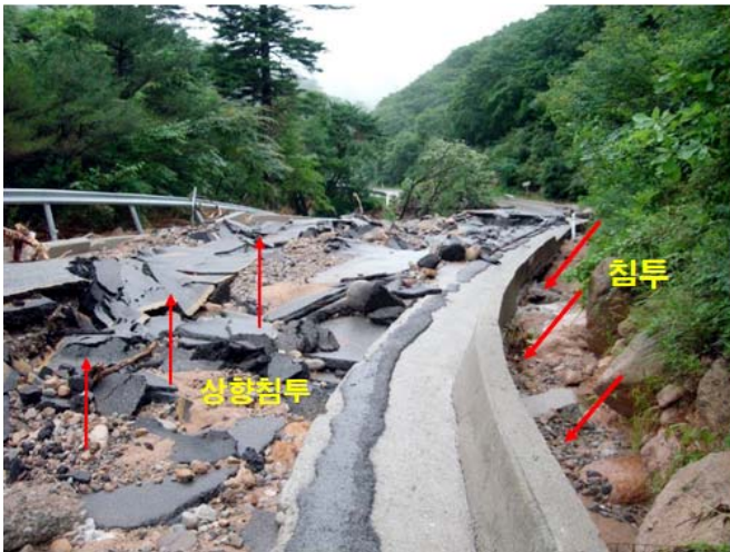
그림 1. 상향침투수압에 의한 포장들림파손(국토해양부, 2007)
