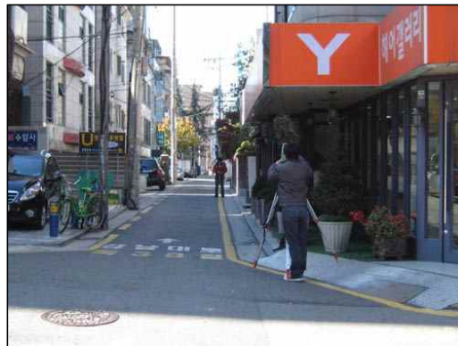
그림 6. 폭 3m 도로에서의 TS관측
