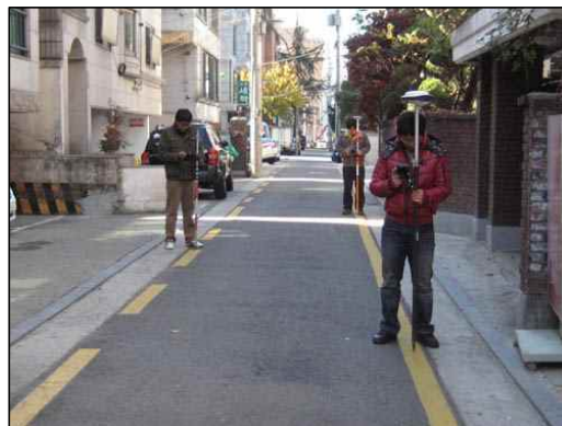
그림 7. 폭 3m 도로에서의 각종 GPS관측
