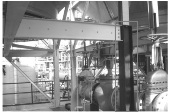
[그림 3] Frame post reinforcement
