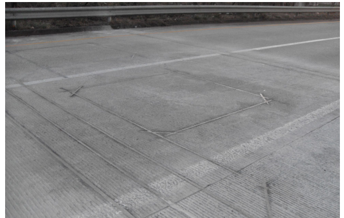
그림 2. WIM시스템 본체 및 설치된 센서
