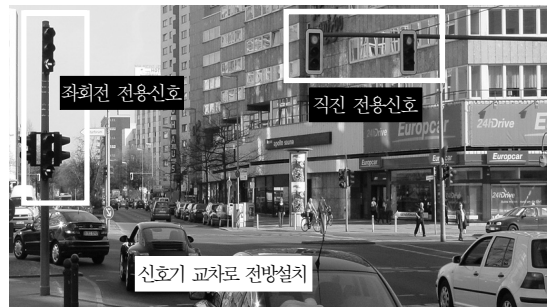
〈그림 6〉 교차로 접근로에 전방 설치된 삼색전용신호등(독일)
