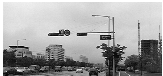
〈그림 4〉 내민식 지주 이용 설치 예시
