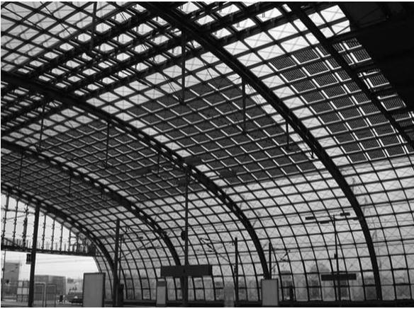
그림 10. 독일 베를린에 위치한 Lehrter Station; 건물일체형 태양광 시스템(면적: 1870m<sup>2</sup>, 용량: 189kW, 시스템 비용 : €3.7 million)
