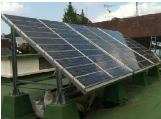
그림 2.  $3\text{kW}$ 급 태양광발전 시스템(개방형구조)
