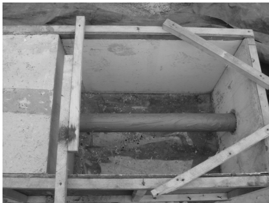
(a) PVC 파이프 표면에 grease를 도포한 모습
