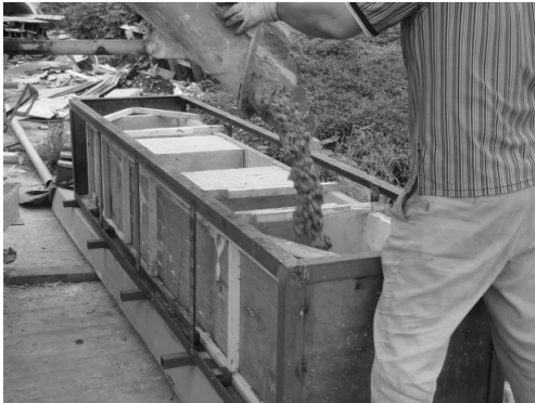
(c) 콘크리트 타설 모습
