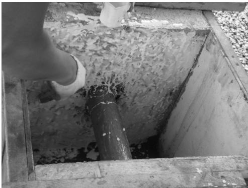
(e) 시공이음부 접합면 아크릴계 접착제 타설 모습
