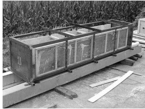
(b) 투수시험용 콘크리트 블록 시료 제작을 위한 목재 거푸집 제작 모습(바깥쪽은 수조 제작용 철재 프레임)
