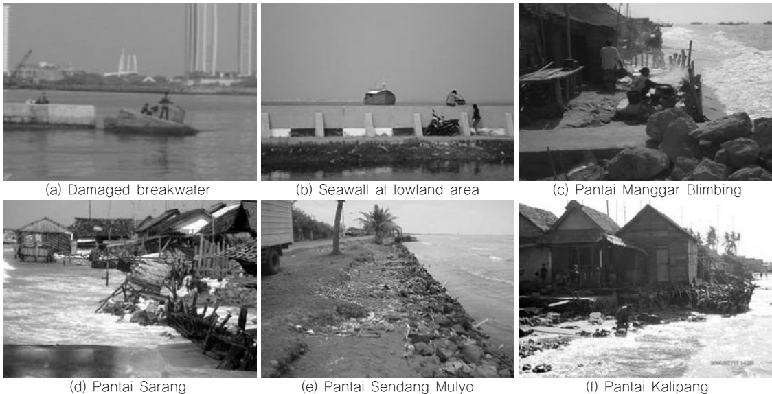
그림 4. Critical coastal areas in Jakarta & Central Java
