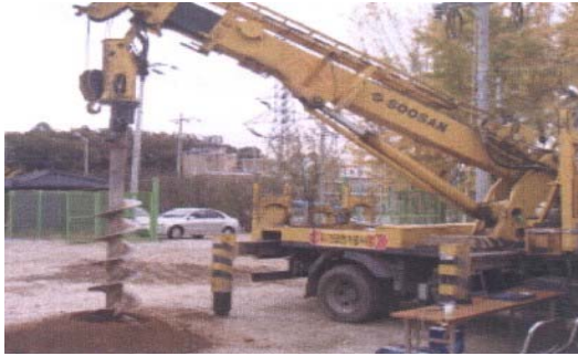
그림 3 신축형 유압식 확장기가 내장된 오거 크레인을 이용한 굴착 사진
