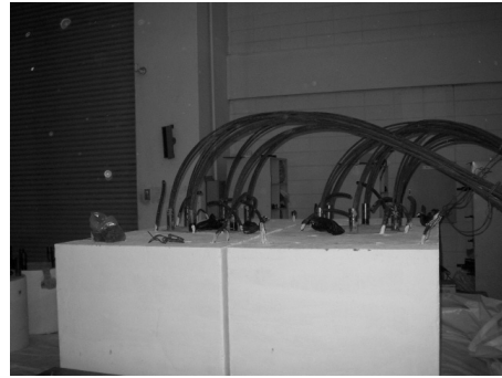
(b) 조립식 기초부 전경
