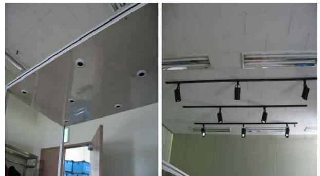
그림 9. 천정매립 및 스포트라이트 설치
