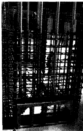
(b) PT 벽체 시공
