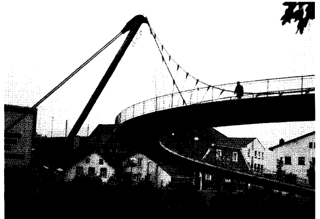
· 켈하임 보도교(1987) : 지지기둥을 바깥쪽으로 편심시켜 기울이고 상판 하중으로 균형을 이루도록 디자인하여 역동적인 이미지를 표현
