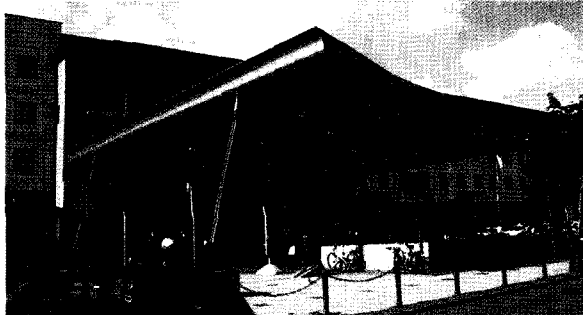
· 움 철도역 (1993) : 케이블의 처짐을 아주 적게하고 케이블에 면해 유리를 마감. 솔라히만 가정자리 보와 뒷당김 케이블로 정착구조 조성
