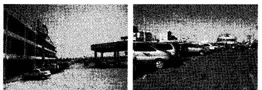
〈그림 3〉 물치항 회센터와 주차장 전경
