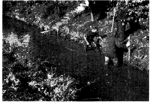
그림 8. 나뭇가지 다발공을 이용한 소하천정비 (하안침식 방지와 서식공간 확보)
