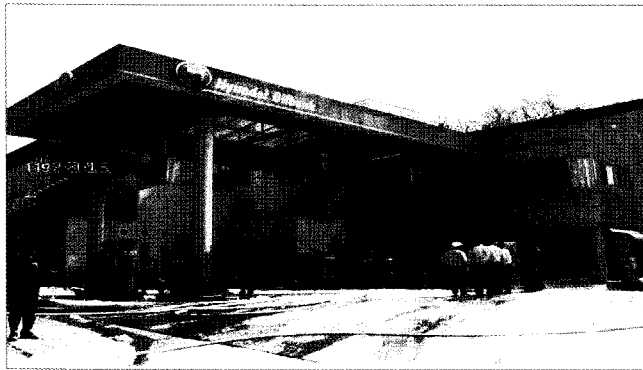
〈사진 5〉 화재 초기진화 후 촬영된 주유소
