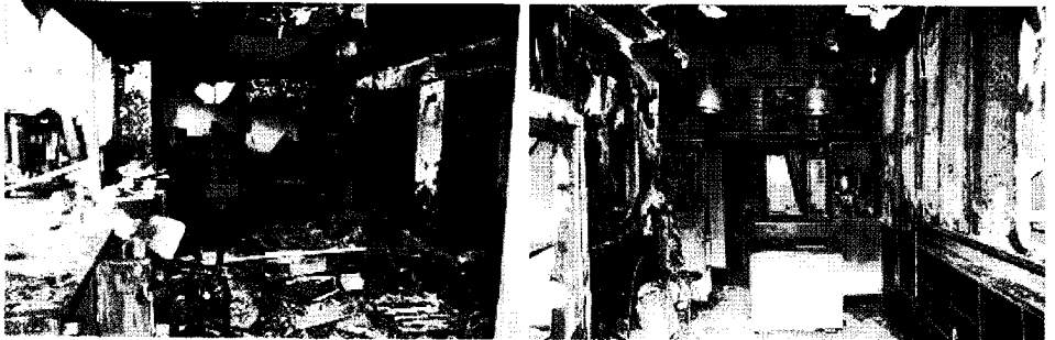
〈사진 8〉 휘발유 유증기에 의한 폭발장소(좌), LPG가스 누출에 의한 폭발장소(우)
