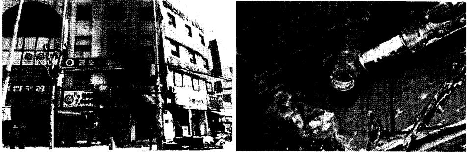
〈사진 7〉 폭발사고 건물(좌), 마감처리가 안된 배관 연결부(우)
