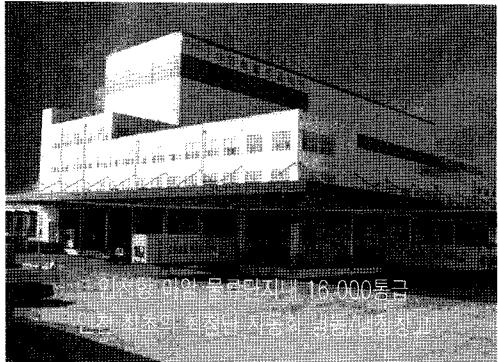
**동** 북아의 물류거점인 인천항 아암물류단지에 최첨단 시설을 갖춘 인천최초의 자동화 냉동·냉장창고가 영업을 개시했다. 총사업비 200억원이 투입된 인천콜드프라자는 부지 15,096m<sup>2</sup>, 연면적 9,752m<sup>2</sup>에 자동화창고(11,000톤), 하이랙창고(3,000톤), 수동식창고(2,000톤)의 복합형 창고로 2008년 12월 1일 전격오픈하게 되었다. 특히, 자동화창고는 로봇인 Stacker Crane이 화물의 입출고를 하기 때문에 신속·정확하며, 창고내로 지게차가 출입 할 수 없기 때-
