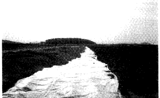
부직포 포설 및 Sand Mat 부설
