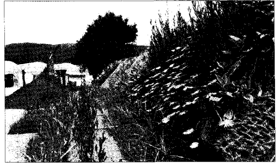
<그림 7> 콘크리트위 식생블럭
